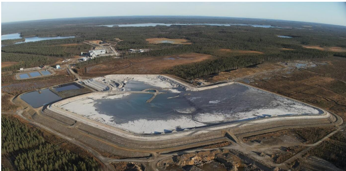
Kuva 12-1. Rikastushiekka- ja allasalue.
