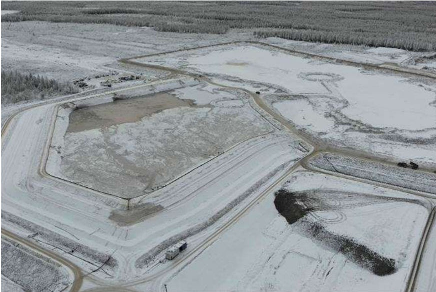
Kuva 7-1. Rikastushiekka-allas ja pyriittiallas marraskuussa 2022.
